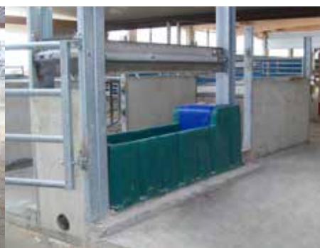
Option I: 1 flotteur MAXIFLOW (l'arrivée d'eau au flotteur est protégée par un câble chauffant 24 V, 20 W, 2 m), 1 résistance 24 V, 180 W
